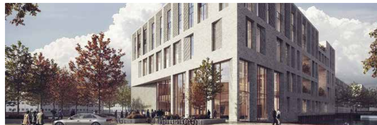
Ny bygning Østre Landsret fra Intra
